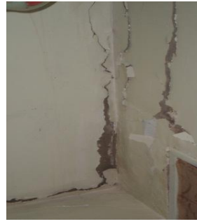
Figure I.9 : Fissure de forme oblique, horizontale ou verticale sur cloisons intérieurs
