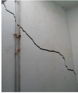
Figure I.9 : Fissure de forme oblique, horizontale ou verticale sur cloisons intérieurs
