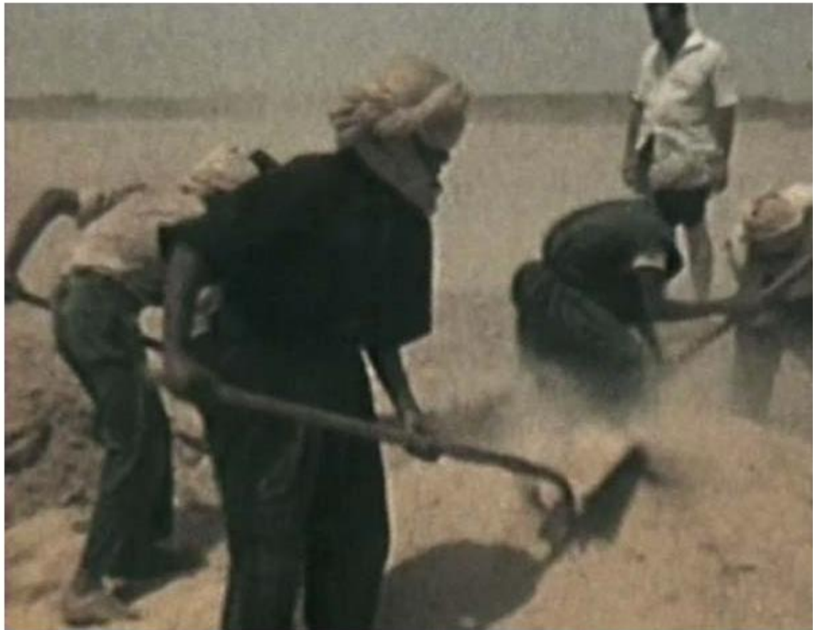
Travailleurs algériens employés à la construction de Reggane. Image 1 sur 9
