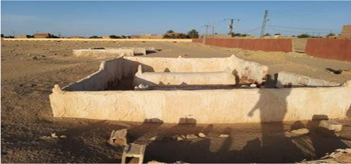
صور أضرحة العلماء البلبالين بقصر بني تامر.
