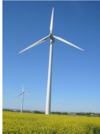
Figure I. 7: Aérogénérateur à axe horizontal.
