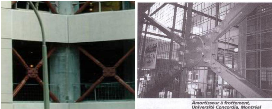
Figure I.7 : Amortisseur à frottement à l'université de Concordia, Montréal [7].
