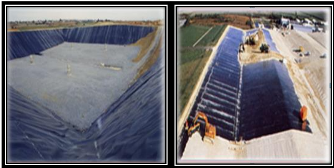
Figure I-5 .Photographie montrant la forme des géomembranes
